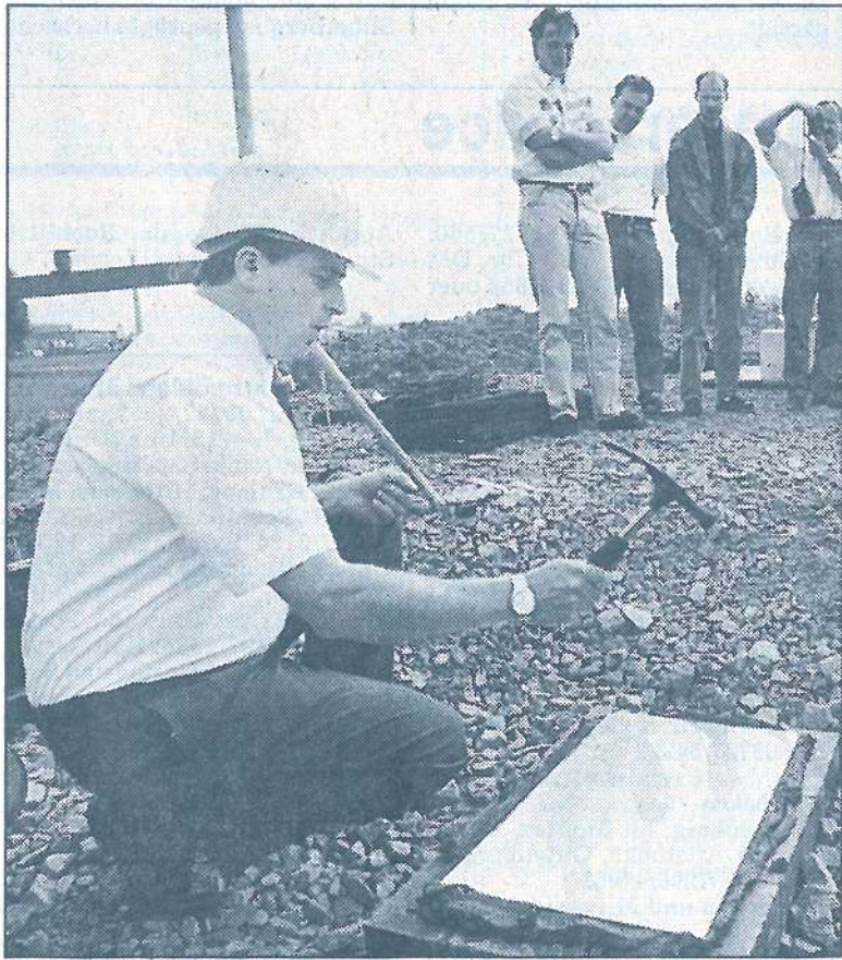
Mit den symbolischen drei Hammerschlägen vollzog Chef Dieter Hartmann die Grundsteinlegung für ein neues Büro- und Sozialgebäude der Firma Medizin und Labortechnik im Gewerbegebiet an der Frankenberger Straße. Foto: Müller
